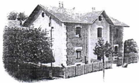
Casa operaia (Tipo C e C bis)
