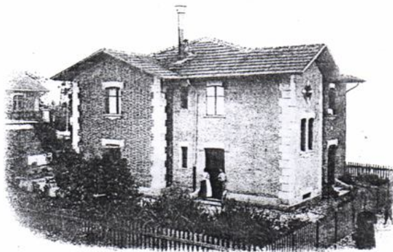
Casa operaia (Tipo E bis)
